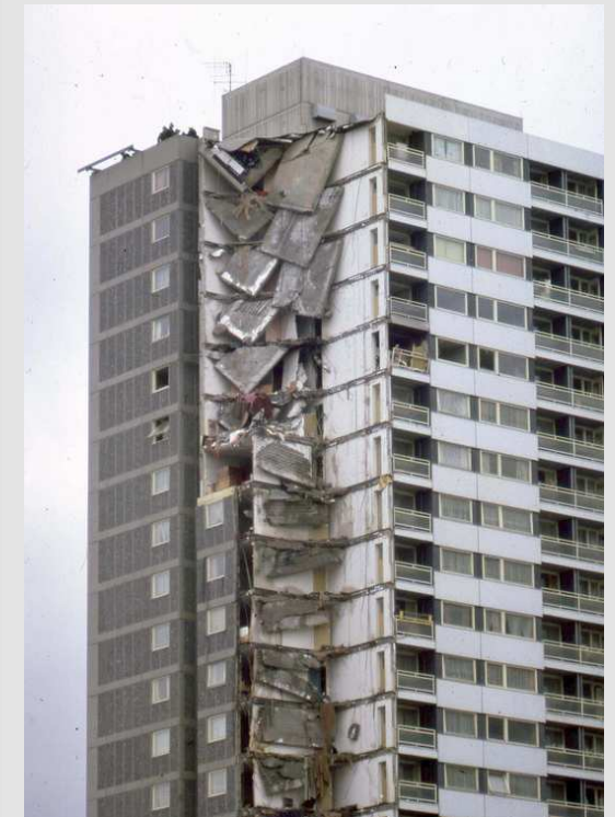
Colapso edifício de habitação social pré-fabricado – Ronan Point – 1968 – Londres
